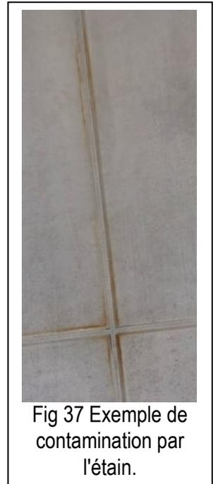
Fig 37 Exemple de contamination par l'étain.
