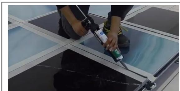
Fig 35 Exemple de scellage avec silicone.
