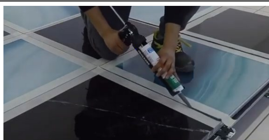
Fig 35 Ejemplo de sellado con silicona.
