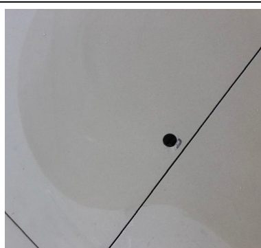
Fig 33 Ejemplo de apertura para cable alimentación lateral
