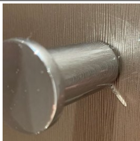
Fig 11 Ejemplo de apriete excesivo
