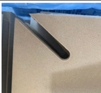
Fig 32 Ejemplo de apertura para cable alimentación en el borde
