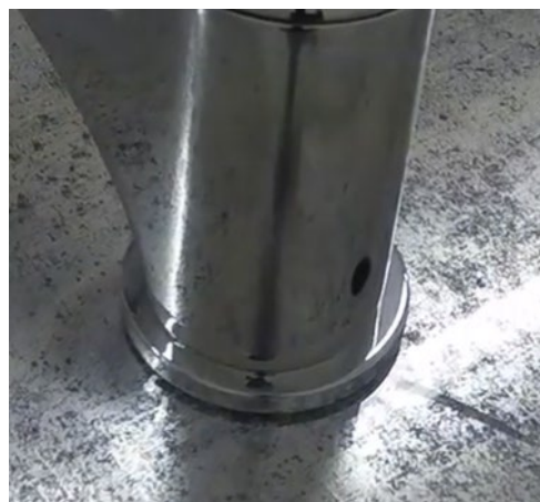
Fig 5 Ejemplo de apriete excesivo
