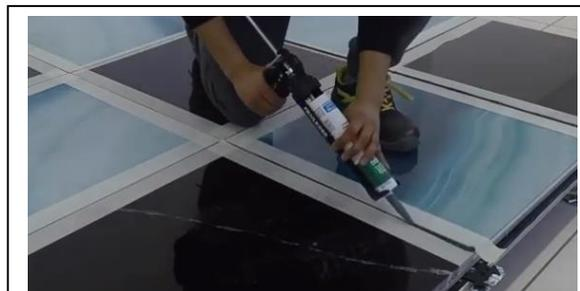
Fig 35 Esempio di sigillatura con silicone.
