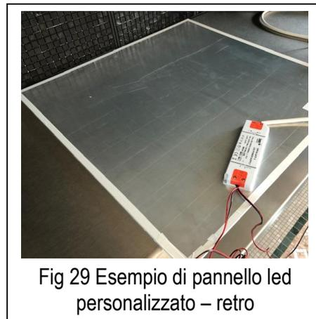
Fig 29 Esempio di pannello led personalizzato – retro
