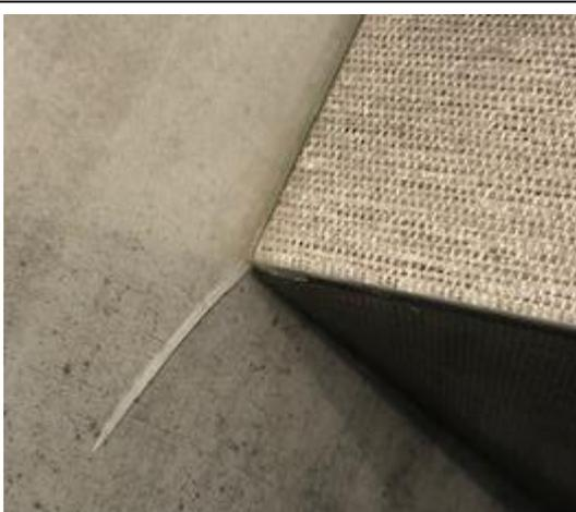
Fig 4 Esempio di spigolo vivo non raggato.
