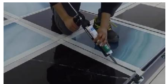
Abb. 35 Versiegelung der Lücken mit neutralem Silikon
