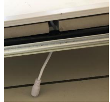
Abb. 34 Beispiel für Steckplatz für den elektrischen Draht
