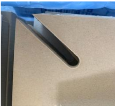
Abb. 32 Beispiel für das Öffnen des Belages, um ein Kabel durchführen zu können
